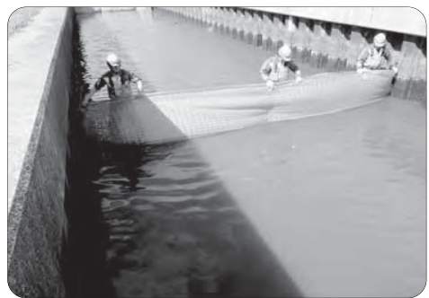
水路工事における生態調査・保護活動
